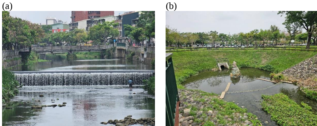
圖 4 萬年溪改造工程-(a)橡皮壩引溪水及(b)復興公園水域
