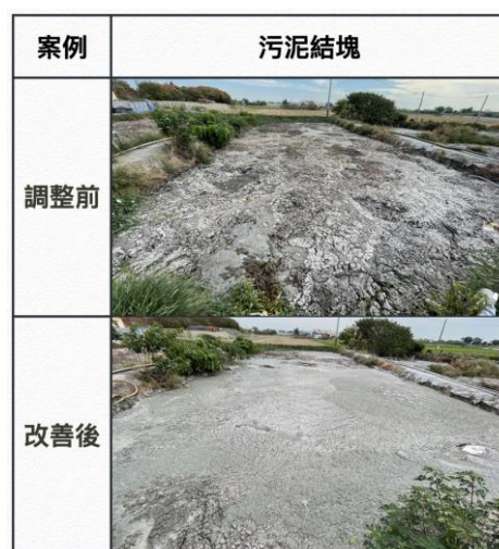
圖 6 表面污泥結塊嚴重的兼氣池
