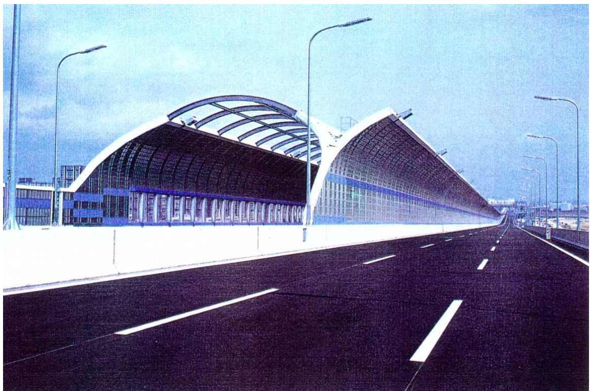
圖八 日本道路半密閉型防音牆
