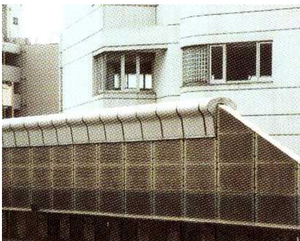
圖十七 日本隔音牆頂緣減音器
