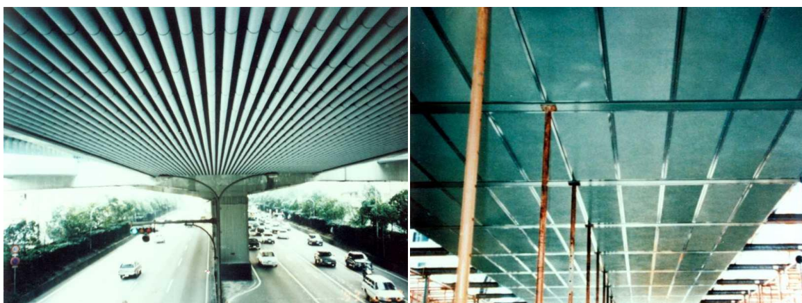
高架橋底部吸音筒
