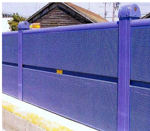
低層隔音牆照片
