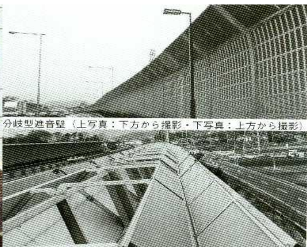
圖十八 日本隔音牆 Y 型減音器
