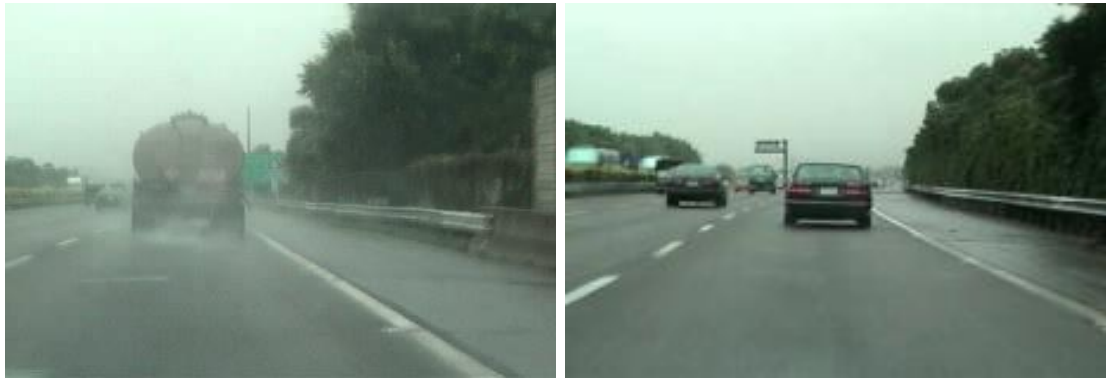
一般路面易積水，行車造成水霧 排水性鋪裝 資料來源：交通部國道新建工程局網站-排水篇；照片位置位於國道三號 132k+513~132k+713 處
