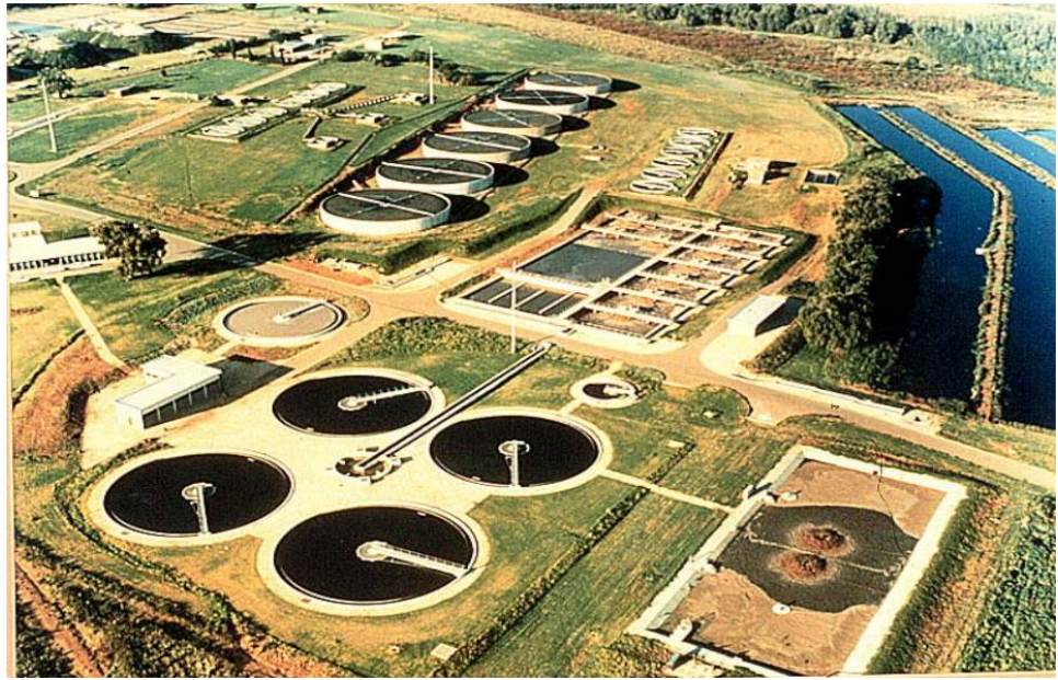
圖 2 南非約翰尼斯堡的 30,000 CMD 污水處理廠之活性初步沉澱池
