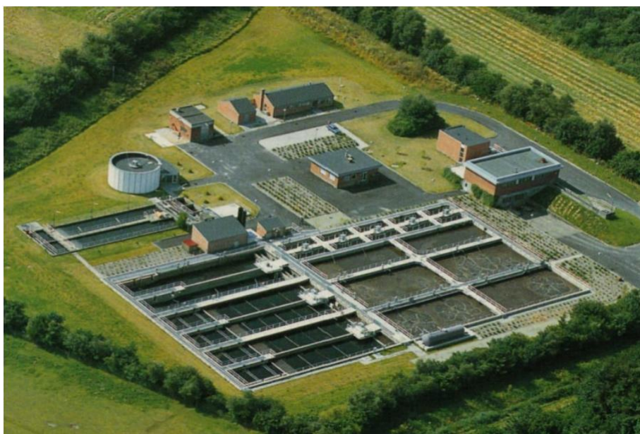
圖 5 丹麥 Fredriksvaerk Melby 污水處理廠之完全混合初沉污泥發酵池
