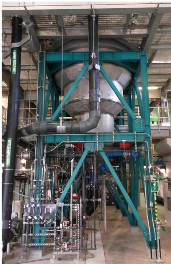
圖 8 磷酸銨鎂回收結晶系統 Pearl® 反應器 [14]
